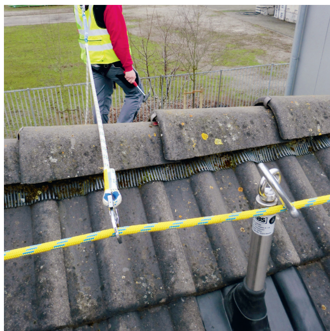
Fig. 9: Système à corde temporaire avec corde à noyau de retenue EN 1891
