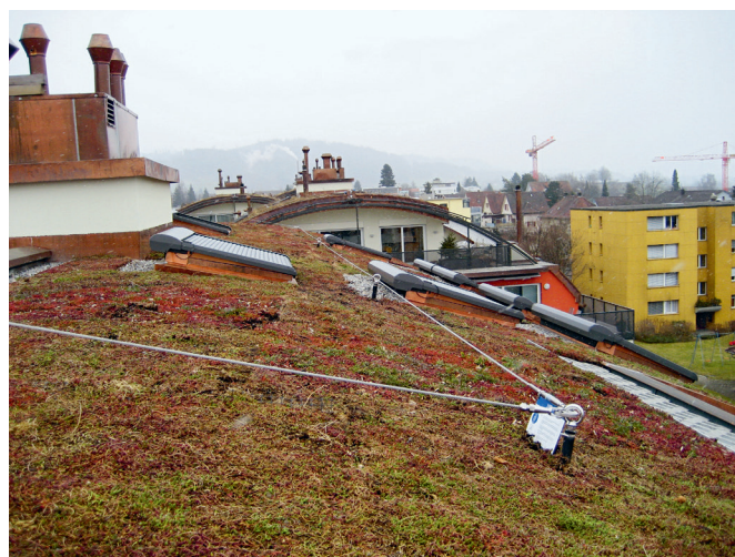
Fig. 6: Classe d'équipement 2; système de ligne de vie sur un toit en berceau végétalisé
